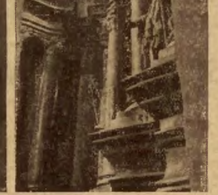
Kolumnada w przejściu do presbiterjum Perspektywa kolumnady oglądana od dołu
