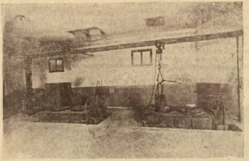
Piece tyglowe z palnikami maneta do temp. 2000 stopni C z lewej strony w „szafce“ piec elekt. do temp. 3000 st. C. (sala termiczna)
