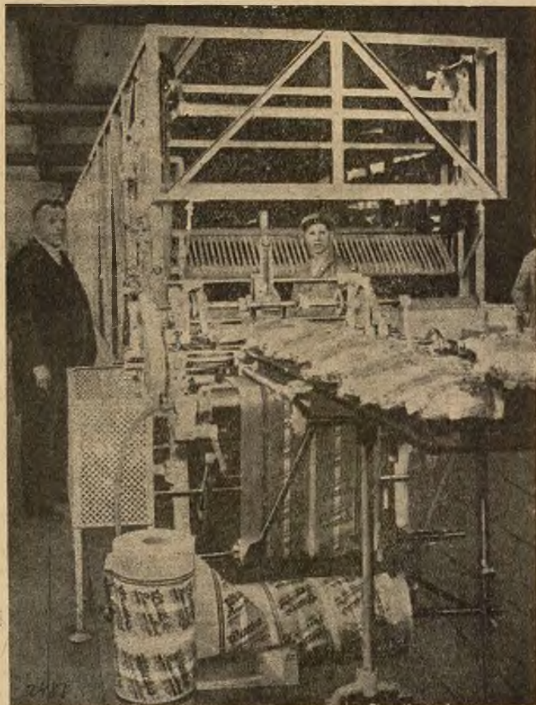
Na wystawie żywnościowej w Berlinie oglądać było można maszynę elektryczną do wyrabiania chleba. Dokonuje ona całego wypieku chleba od ciasta aż do gotowego chleba.
