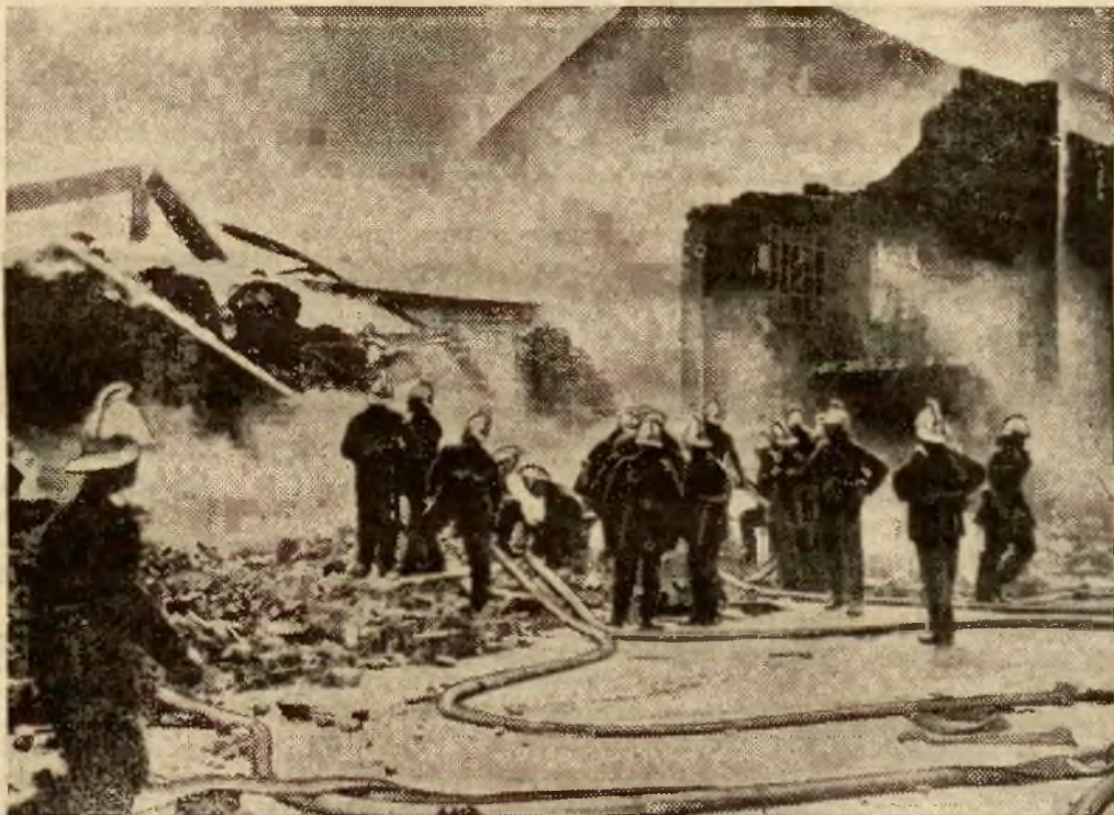
W dokach londyńskich wybuchł tak groźny pożar, że straż ogniowa w ilości przeszło 300 ludzi, z trudem zdołała go opanować. Ponieważ palące się mury zawalily, — zginęło dwóch strażaków, a kilku odniosło rany.
