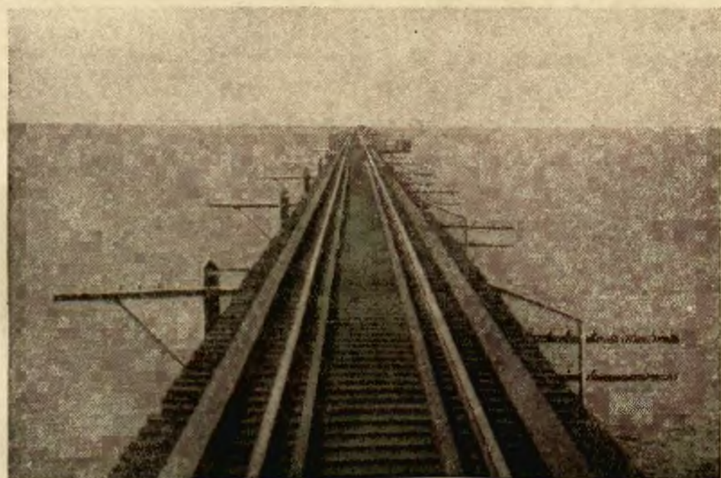
Huragan, który nawiedził Florydę i spowodował około 700 ofiar w ludziach, zniszczył linię kolejową, oraz pochłonął cały pociąg. Linia kolejowa łączyła poszczególne wysepki i prowadziła jak to widzimy na zdjęciu wprost przez morze. W pociągu znajdowali się uciekinierzy z poszczególnych wysepki, przeważnie weterani.
