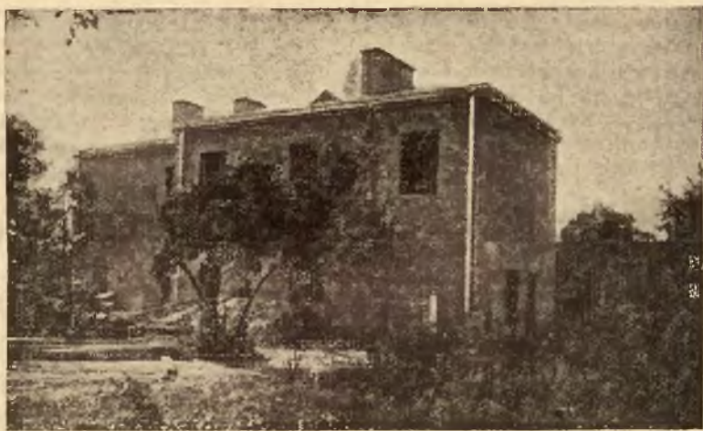
Nowobudująca się Szkoła Powszechna Nr. 18 przy ul. Zwirki i Wigury. Fundusze na budowę łoży Zarząd Miasta i Tow. Budowy Szkół Powsz.
