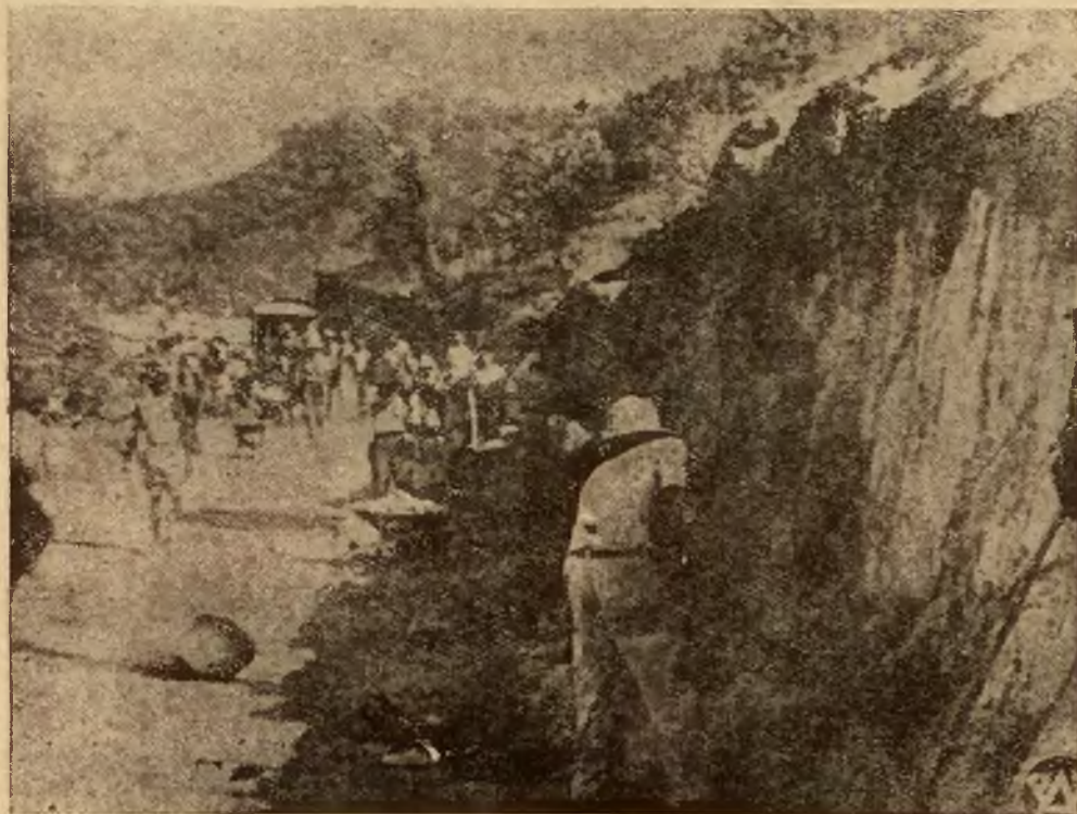
Budowa drogi, prowadzącej do Adui.
