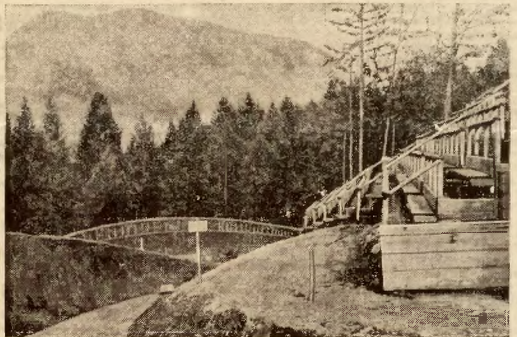
Najnowsze zdjęcie toru bobsleighowego w Garmisch-Partenkirchen. Na wielkiej krzyżźnie.
