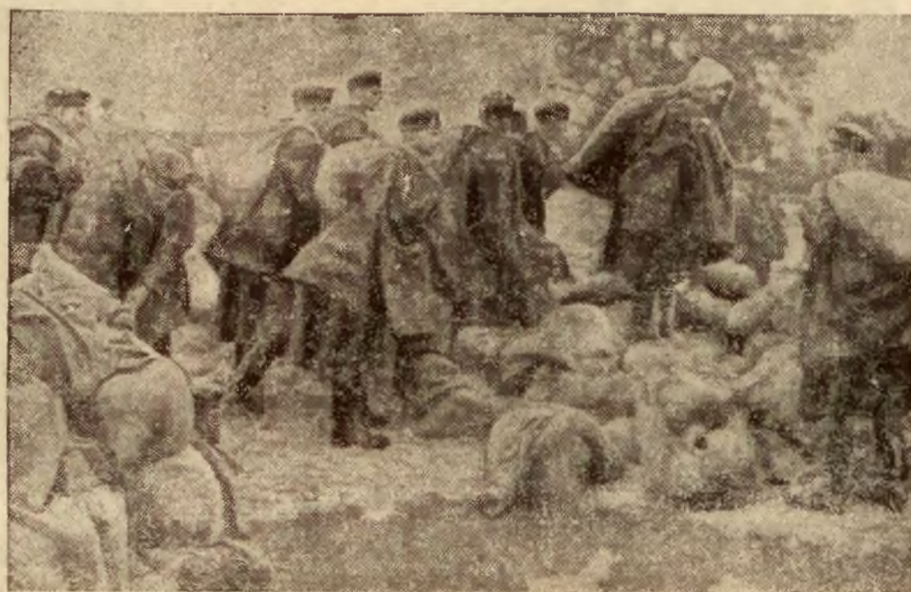
Na wybrzeżu morza Północnego burza poczyniła znaczne spustoszenia. Na zdjęciu umacnianie nadwyżonej grobli.
