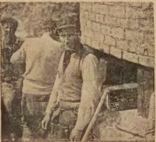
Na rycinie robotnicy zajęci niszczeniem fundamentów komina, które następnie zastępuje się drewnianymi podporkami. Podporki podpala się i komin się wali.
