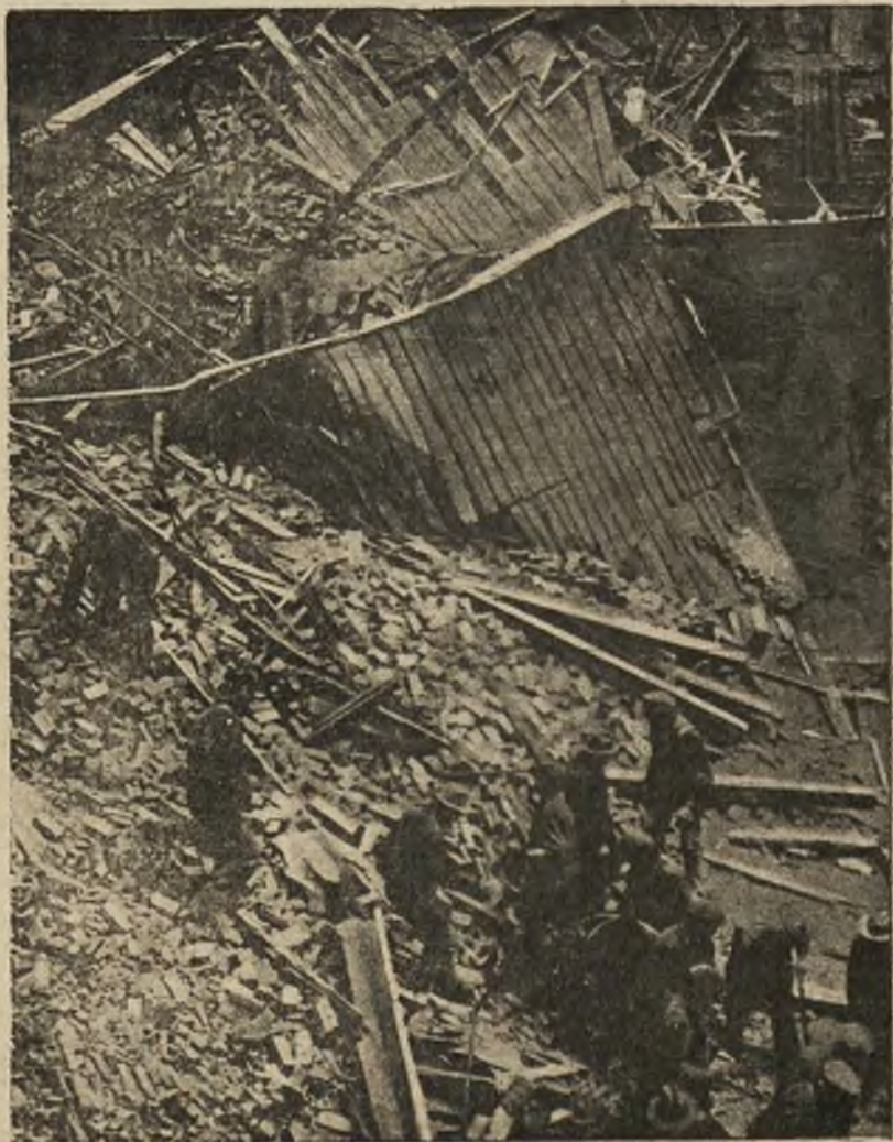
Wskutek rozkopywania tunelu kolejki podziemnej w Nowym Jorku, runął 4-ro piętrowy dom grze- biąc pod swemi gruzami 40 osób.
