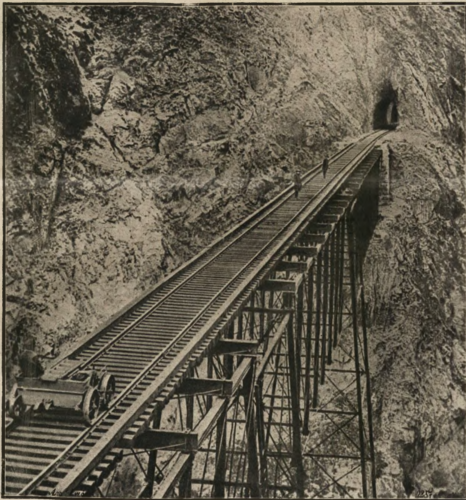
Most Chaupichaca i tunel kolei żelaznej w Peru należą do najpotężniejszych dzieł techniki nowoczesnej.
