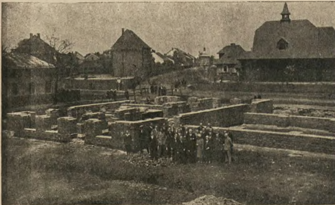
Fundamenty nowobudującego się Polskiego Domu Ludowego T. S. L. w Lewandówce.
