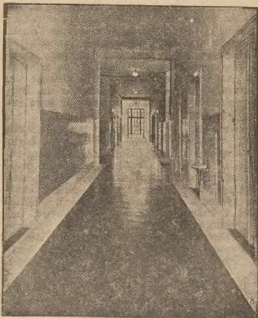
Korytarz lewego skrzydła kliniki.
