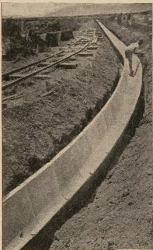
Budowa kanału w Palestynie celem osuszenia terenów kolonizacyjnych.
