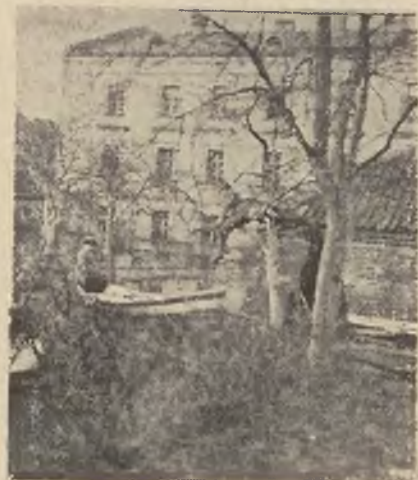
Dostęp do posesji przy ul. Zygmuntowskiej możliwy był tylko przez ogrody od ul. Mostowej. Na zdjęciu widzimy jedną z prowizorycznych „przystani”
