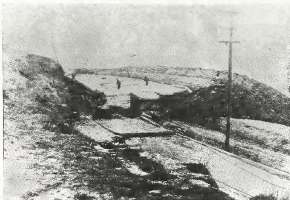
Koło San Francisco nastąpiło obsunięcie się ziemi, które spowodowało znaczne szkody materialne. Prowadząca tamteży szosa asfaltowa obsunęła się o 20 metrów, powodując zerwanie przewodów kanalizacyjnych, gazowych i kabli telefonicznych. Na zdjęciu zniszczona szosa.
