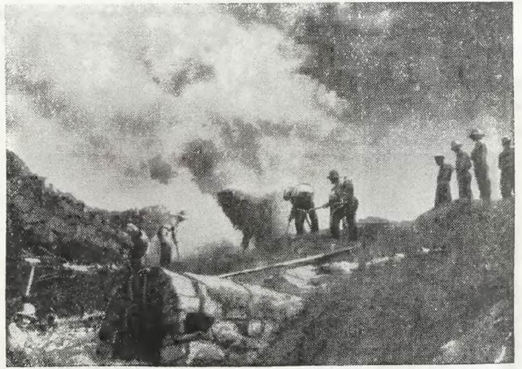
Włosey robotnicy podczas budowy drogi w Abisynji
