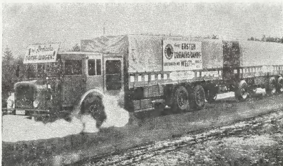
W Niemczech wyprodukowano powyższy potrójny samochód, poruszany parą.
