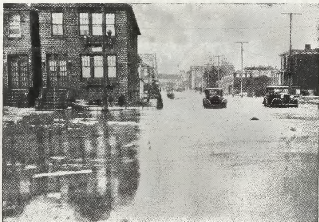
Stany Zjednoczone nawiedziła katastrofalna powódź. Na zdjęciu ulica w Woodridge - Queens w stanie New York.
