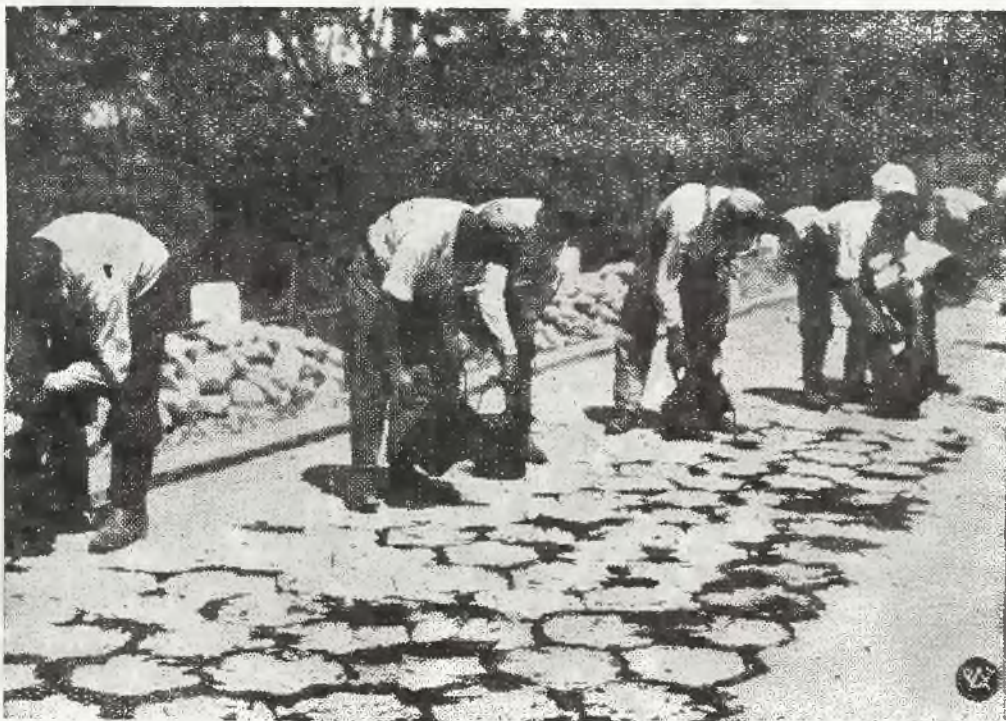
Zdjęcie nasze przedstawia budowę szosy pod Zegrzem (woj. Warszawskie) z kostek betonowych.
