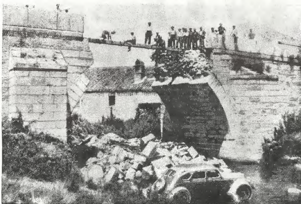
Zniszczony przez obrońców ładu ludowego most na rzece Guadarram
