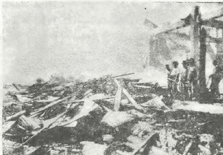
Zdjęcie nasze przedstawia budowę na jednym z największych placów Haify, podpalone ostatnio i doszczętnie zniszczone przez Arabów.
