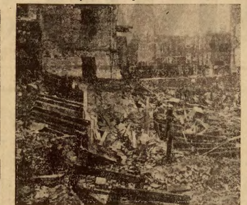
W dzielnicy Staten Island w New Jorku zawaliły się wskutek burzy połączonej z ulewą, trzy domy. 18 osób zostało pogrzebanych pod gruzami.
