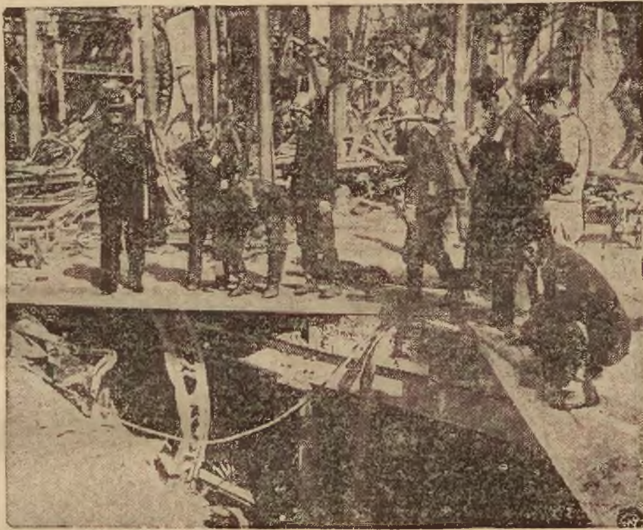
Moment gaszenia flejących jeszcze zgliszcz olbrzymich magazynów w Marsylii, które spłonęły podczas ostatniego pożaru
