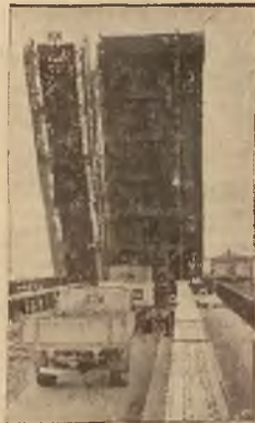
Wyspa Rugia w Niemczech (do czasów Bolesława Krzywoustego należała do Polski) została połączona mostem ze słynnym lądem. Jedną przelotem tego mostu można podnieść aby przepuścić okręty.
