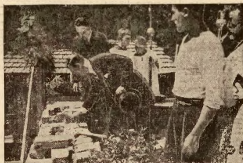
W Sofii odbyło się uroczyste poświęcenie kamienia węgielnego i założenie fundamentów pod budowę nowego gmachu Poselstwa Rzeczypospolitej w Sofii.
