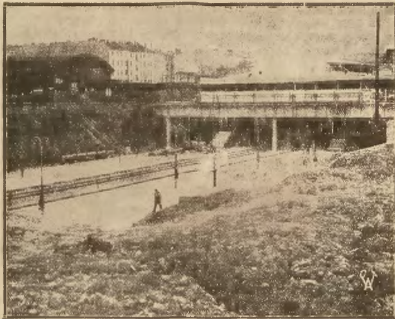
Widok na nowy tymczasowy dworzec średnicowy w Warszawie po zburzeniu okalającego go w Aleji Jerozolimskiej. Widoczne są podjazdy po obu stronach odkrytego tunelu oraz perony betonowe, na których ustawiono już 4-ramienne wysokie latarnie elektryczne. Tory na tem miejscu są całkowicie wykończone.
