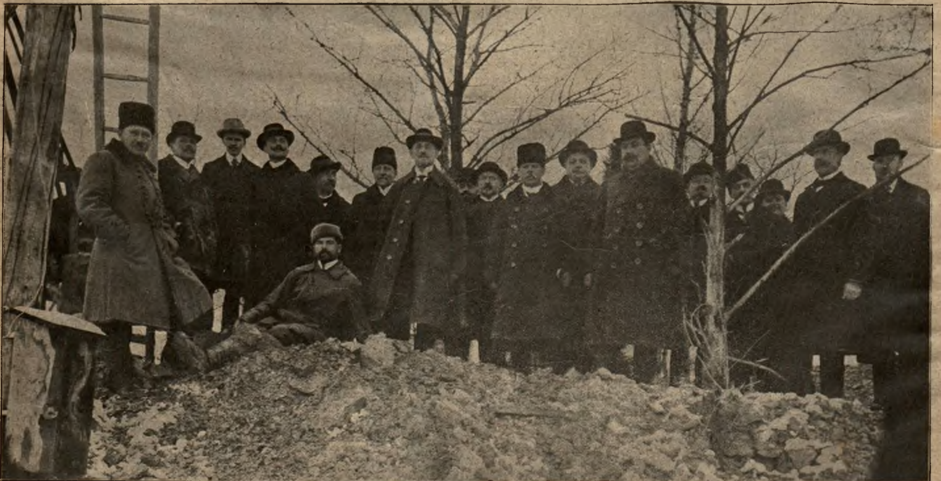
Tunel pod Wisłą: Grupa uczestników uroczystości przebicia tunelu dla celów wodociagowych pod krakowskiemi Bielanami.
