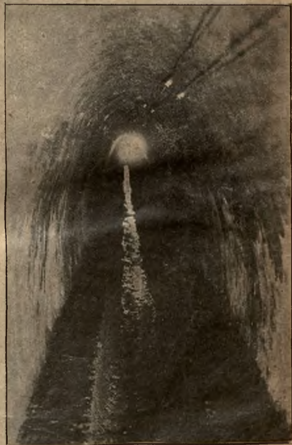
Tunel pod Wisłą: Wnętrze tunelu dla przeprowadzenia rury wodociągowej, wybudowanego pod korytem Wisły koło Bielan pod Krakowem.
