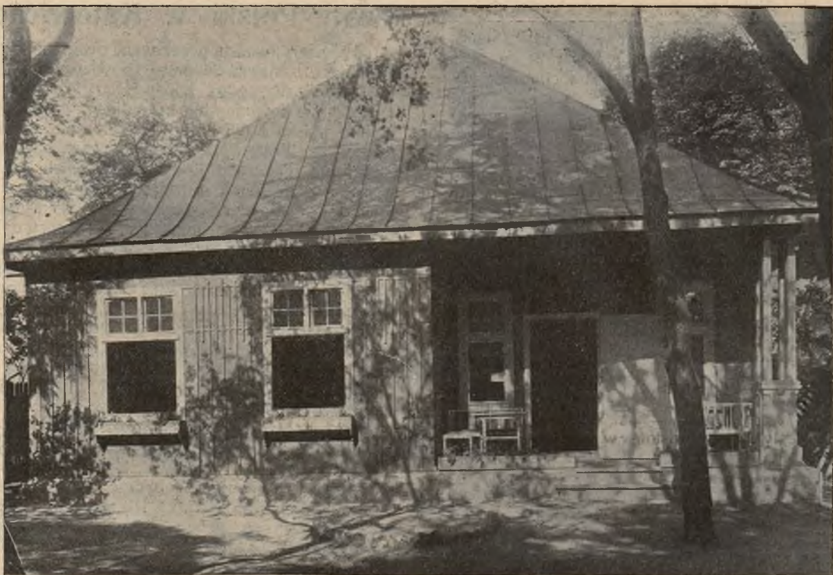
Ze Śląska. „Dom metalowy” zbudowany w Katowicach przez fabrykę domów metalowych w Żorach według pomysłu inż. Förstera.
