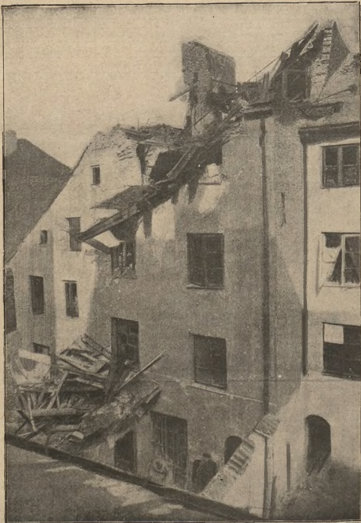
Z Warszawy: Dom przy ulicy Rycerskiej (w pobliżu Zamku królewskiego) uszkodzony wybuchem w dniu 6. sierpnia. (Według fot. warszaw. „Tyg. Illustr.“)
