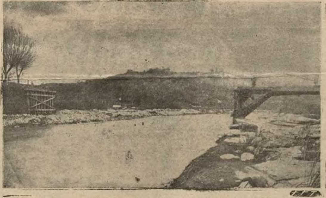
Fatalne skutki wiosennych roztopów: Zniszczony przez powódź most na Popradzie pod Starym Sączem. Fot. Bracia Dworzak, Nowy Sącz.
