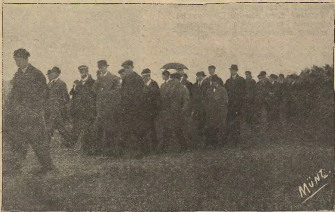
Budowa II. Domu Techników we Lwowie Pochód techników na miejsce budowy w dniu uroczystego jej rozpoczęcia.
