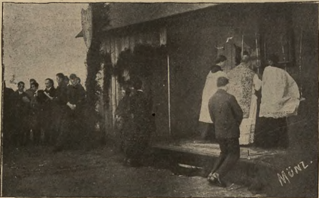
Budowa II. Domu Techników we Lwowie: Msza św. polowa, odprawiona przez ks. Czajkowskiego, na miejscu rozpoczęcia budowy.
