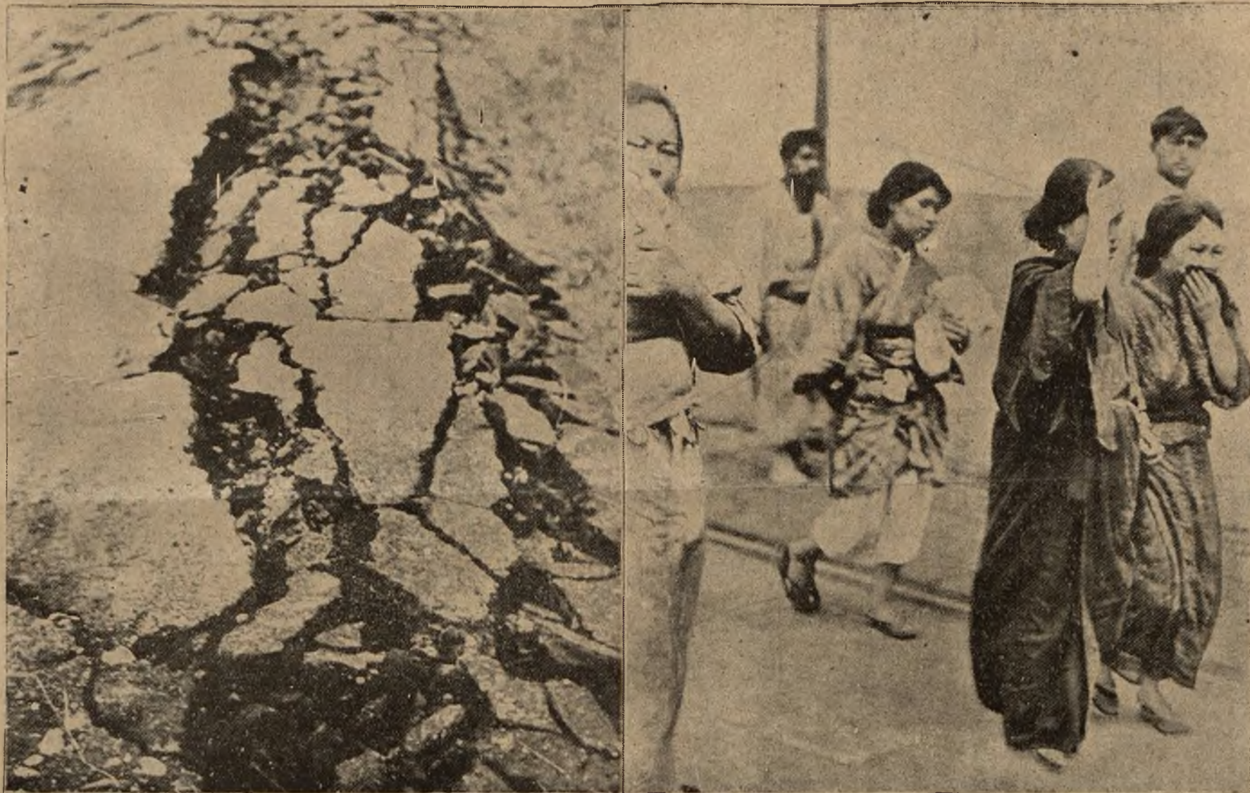
Japonia w gruzach i żałobie : Rozpadlina na gościńcu do Jokohamy, spowodowana trzęsieniem ziemi.
