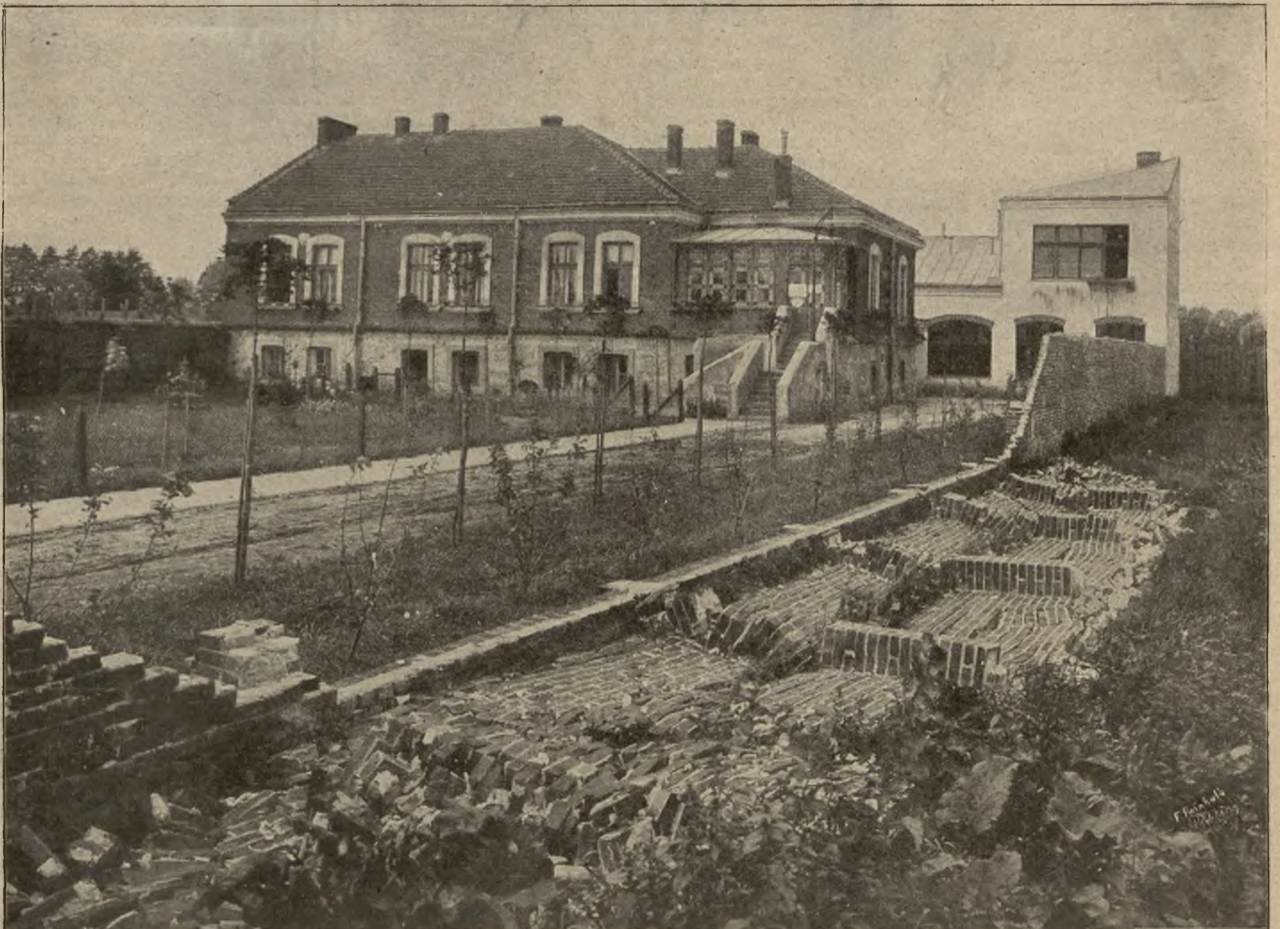
Katastrofy budowlane: Dom „Nowości Ilustrowanych“ z murem, przewróconym przez wichurę.
