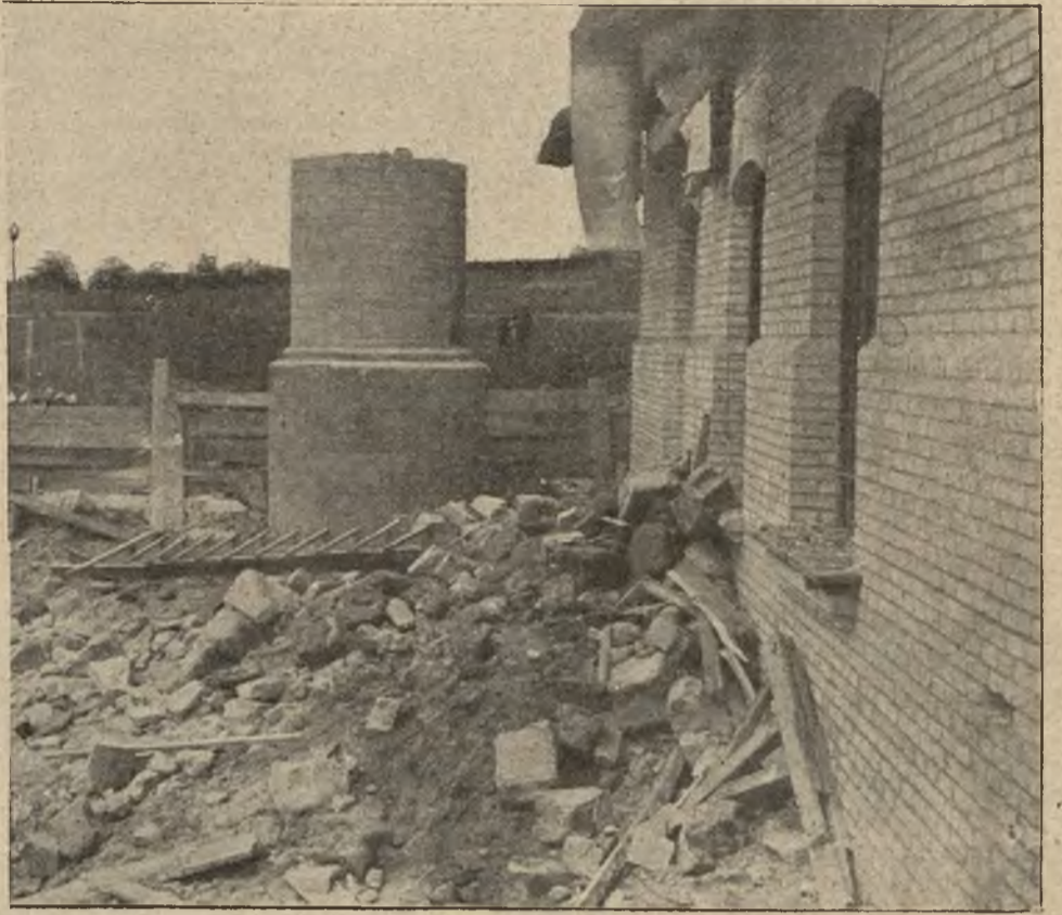
Katastrofy budowlane: Szczątki zawalonego komina fabrycznego przy ulicy Janowskiej we Lwowie. (Fot. M. Münz, Lwów)
