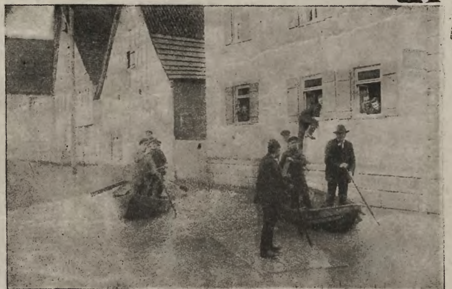
Kłęski powodzi w Europie: Z powodu zalania przez wodę ulicami i partycywnych do mieszkań wchodzi się przez okna.
