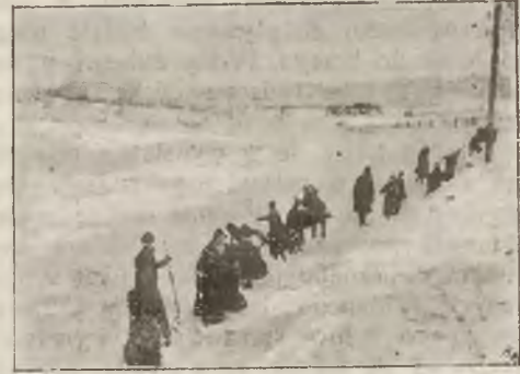
Uprzątanie śniegu z toru kolejowego.
