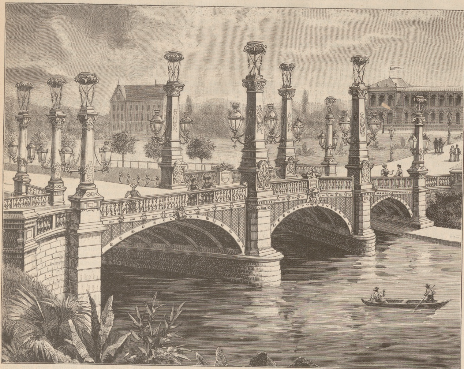
Die Universitätsbrücke in Straßburg i. G. (S. 403)
