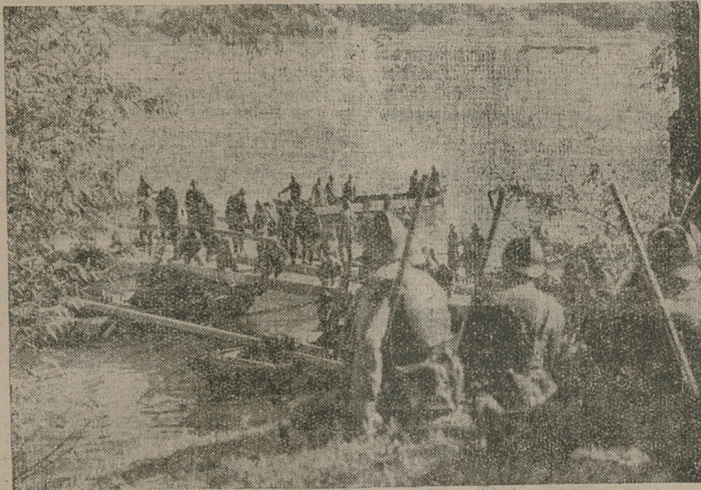
W Jugosławji odbywają się obecnie jesienne manewry, w których udział bierze cała armja. Na zdjęciu oddział żołnierzy zajętych budową mostu pontonowego.
