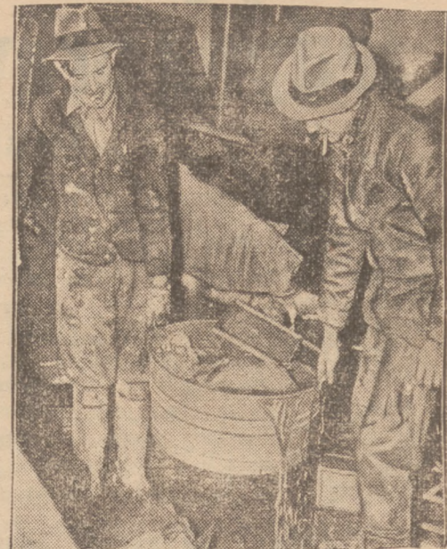
Mieszkańcy dotkniętych klęską powodzi miast St. Zjednoczonych, powracając po opadnięciu wód, do domów, w których, rzecz jasna, zastają okropny obraz. Oto porządkowanie jednego z mieszkań, położonego na drugim piętrze domu.
