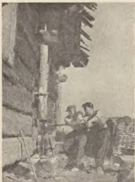
Chałupa Sabały w czasie remontu
