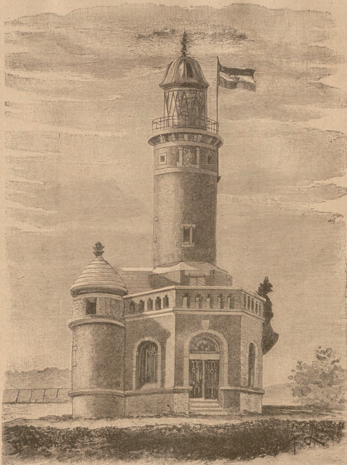
Der Leuchtturm mit der Drei-Kaiser-Halle bei Holfenau. (Text hierzu auf Seite 32.)
