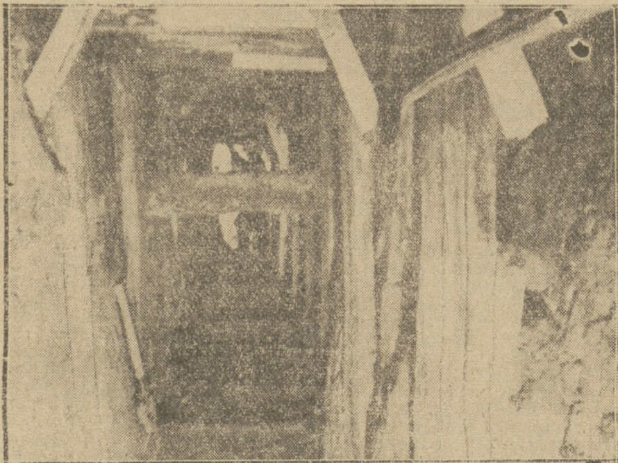
TUNEL POD MARSZAŁKOWSKĄ
