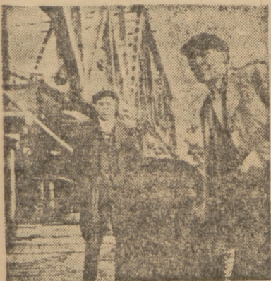
Tow. Linowski na „dzwonie” w którym na głębokości kilku metrów pod wodą prowadzi się prace przy odbudowie filarów mostu na Rgilicy
