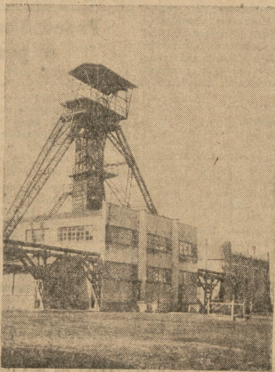
Wieża wyciągowa w kopalni soli w Wapnie
