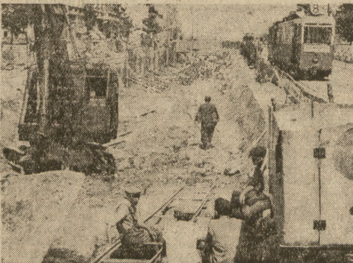
Prace przy poszerzaniu tunelu linii średnicowej w Warszawie postępują szybko naprzód.
