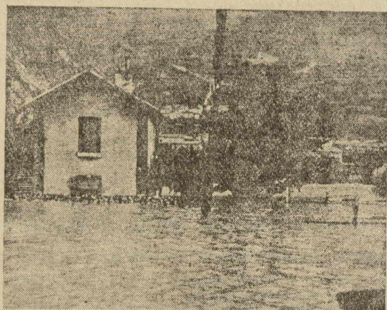
W południowo-wschodnich górskich częściach Francji w rezultacie długotrwałych deszczów wylały rzeki
