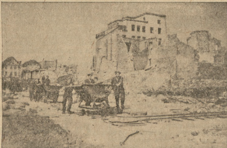
Pomagają wydatnie w jej odbudowie junacy „Służby Polsce”, których wiele pracuje przy odgruzowaniu miasta.
