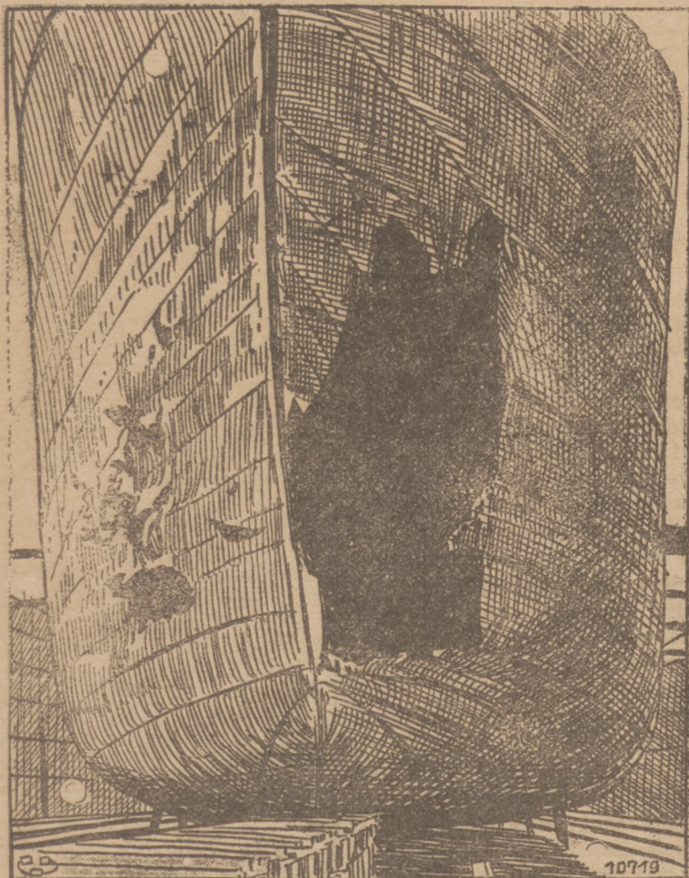
Spód okrętu handlowego, zniszczonego przez torpedę.
