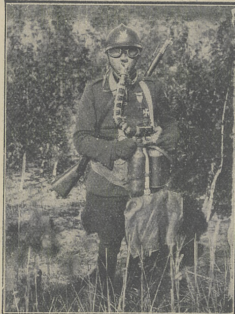
Żołnierz w aparacie tlenowym syst. Dregiera, używanym podczas długiego pobytu w chmurze gazowej lub podczas walk minowych w korytarzach podziemnych.
