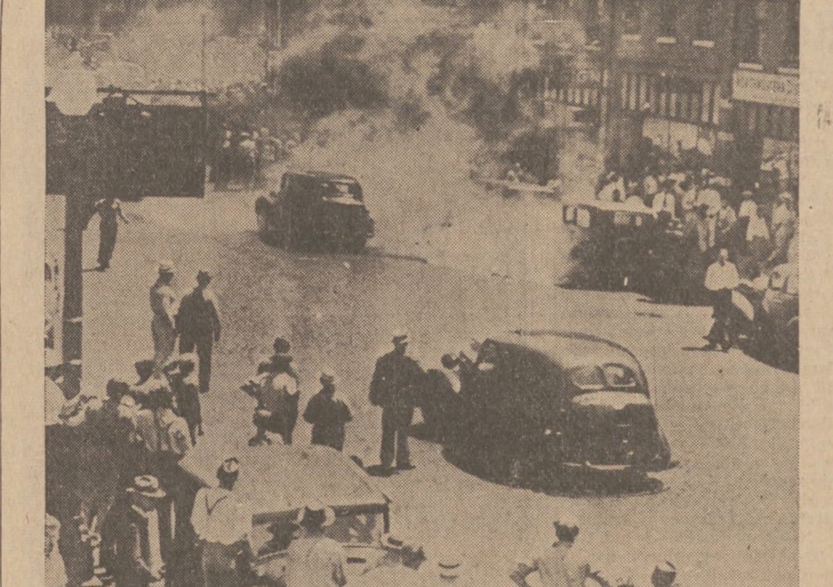
Policia z Minneapolis, Minn. zmuszona była użyć gazu łzawiącego do rozprószenia strajkujących pracowników z WPA gdy doszło do krwawych zaburzeń w których czterech osób zostało poważnie poranionych a jedna osoba zabita.
